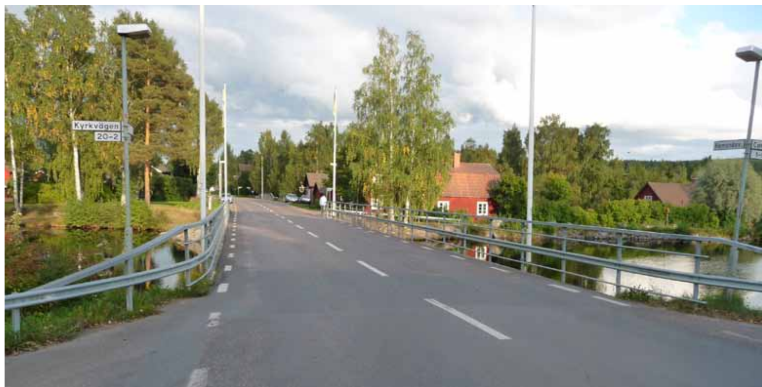
Bron - nuvarande utseende är "en bit landsväg" snarare än en bro i byn"
