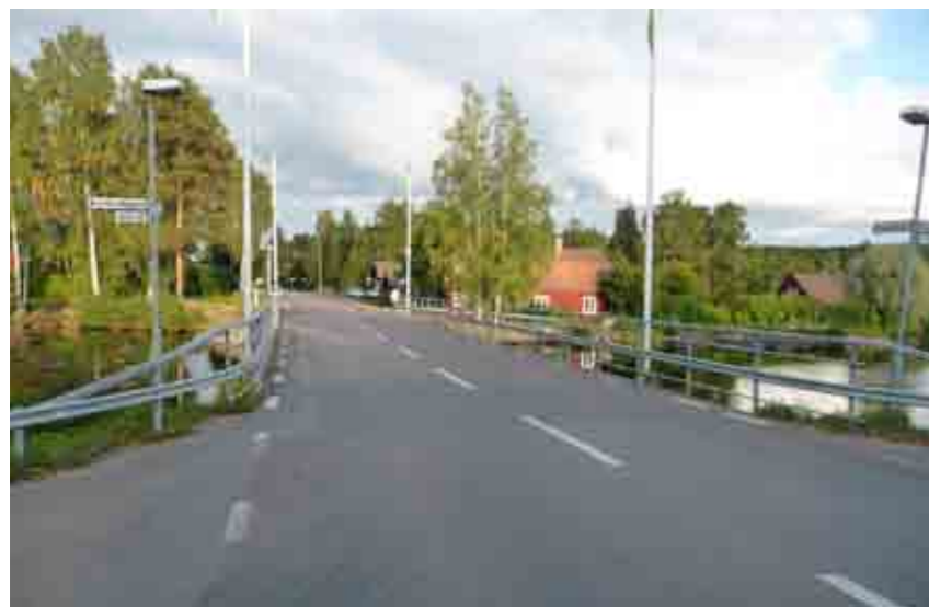
nuvarande utseende är "en bit landsväg" snarare än en bro i byn"
