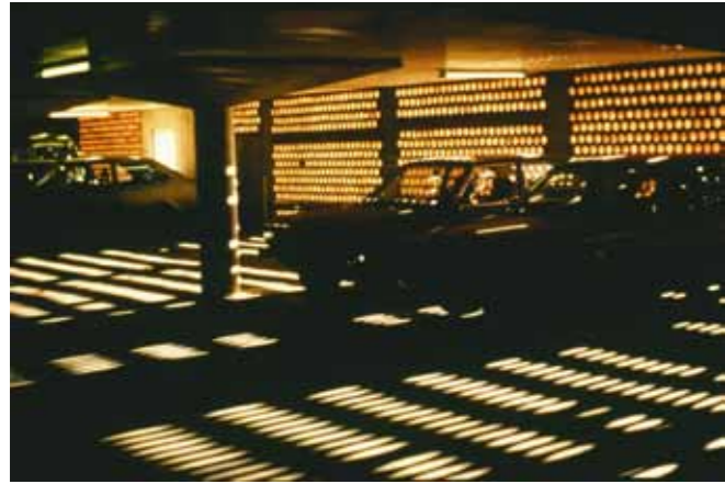
Souterräng för garage och verksamheter/Arken
